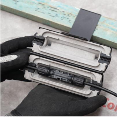
Coloque la conexión de CC en la caja ArcBox con los cables tendidos en el pasacables.
